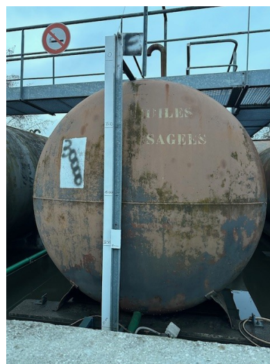
Exemple d'une cuve huiles usagées avec niveau de remplissage
