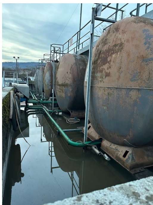
Rétention des cuves huiles usagées remplie d'eaux pluviales/ boîtiers d'alimentation électrique des réchauffeurs de tuyaux associés aux cuves, presque immergés et déconnectés électriquement
